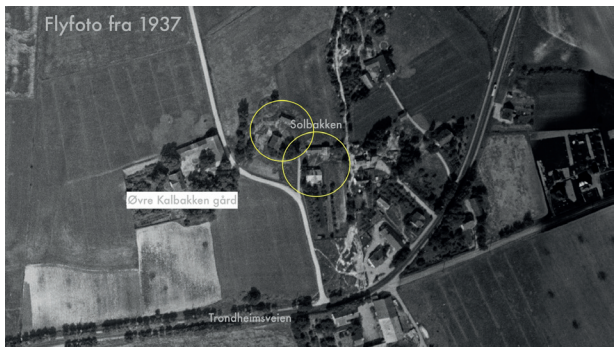
Tor Paulsens innplotting av de tre gårdene på et flyfoto fra 1937. Øvre Kalbakken gård og Solbakken med bruksnummer 33 er godt vedlikeholdt og bebodd i dag, mens Solbakken med bruksnummer 35 (øvre sirkel) er revet.
